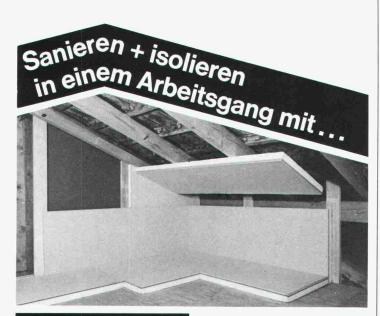
WESPAN-Normisolierelemente sind als Boden-, Wand- und Deckenisolierplatten genormt, allseitig genutet und einseitig mit Polystyrol-F20 oder mit Flumrocplatten beschichtet. Div. Platten- und Isolationsstärken. K-Werte bis 0,32 W/m² K. Einsparung von ca. 30–50% Arbeitskosten. Isolieren, sanleren in einem Arbeitsgang. Keine Kältebrücken u. Fugen (Nut- und Federverleimung)
