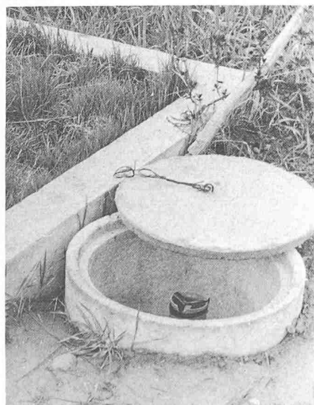
Bild 4. Kunststoffrohr zum periodischen Absaugen phosphatreichen Schlammes aus der untersten Schicht
