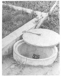
te der Anlage und ist bis zum Behälterboden geführt. Auf der Gegenseite fliesst das gereinigte Wasser wenig unter dem Beckenrand zum Vorfluter. Schwankungen in der Wasserzufuhr -Abwasserstösse oder Starkregen gleicht ein Heber aus, so dass ein Überlaufen der Anlage unmöglich ist. Infolge periodischer Absenkungen des Wasserspiegels erhält der Wurzelraum zusätzlichen Luftsauerstoff. Die überschüssige Biomasse wird zudem an die Oberfläche gestossen, wo sie verschiedene Organismen abbauen.
