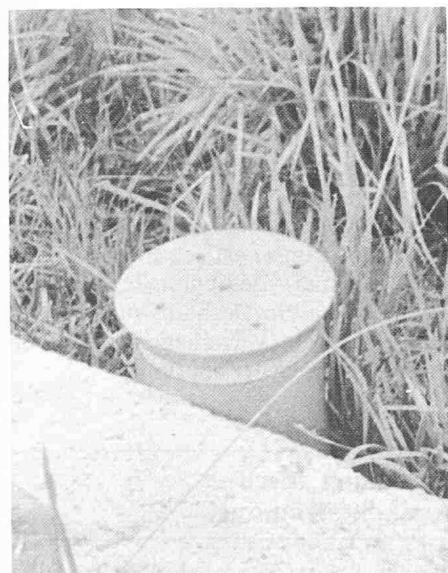
Bild 3. Auslaufschacht
