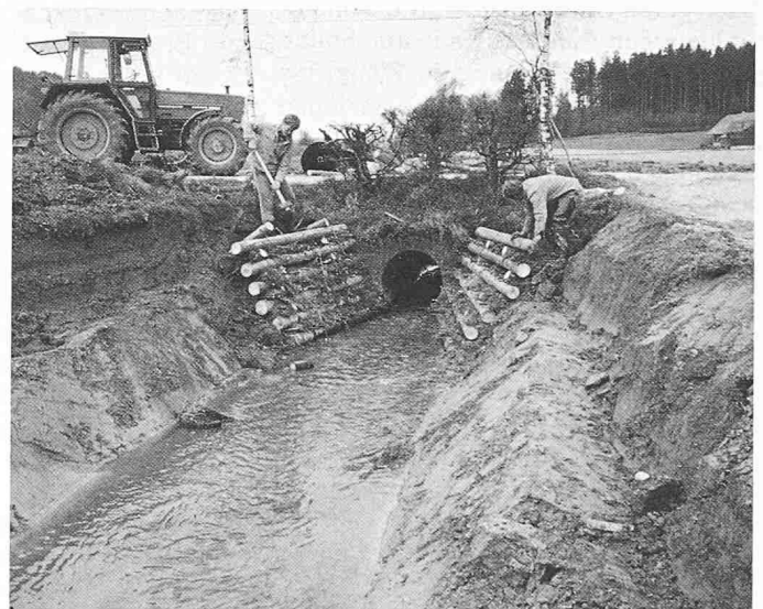
Bild 2. Schwarzbach: Holzgrüenschwellen bei Ein- und Ausmündungen von Rohren werden vom Gemeindewerk erstellt
