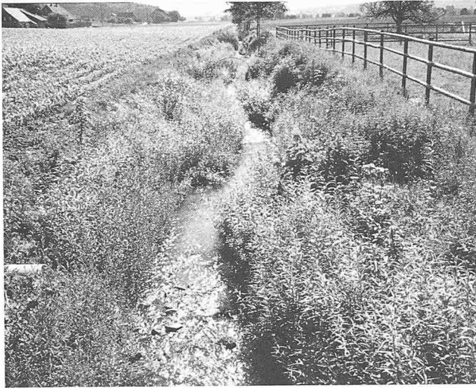
Bild 5. Schwarzbach: Aufwuchs der ingenieurb biologischen Verbauungen nach 3 Monaten
