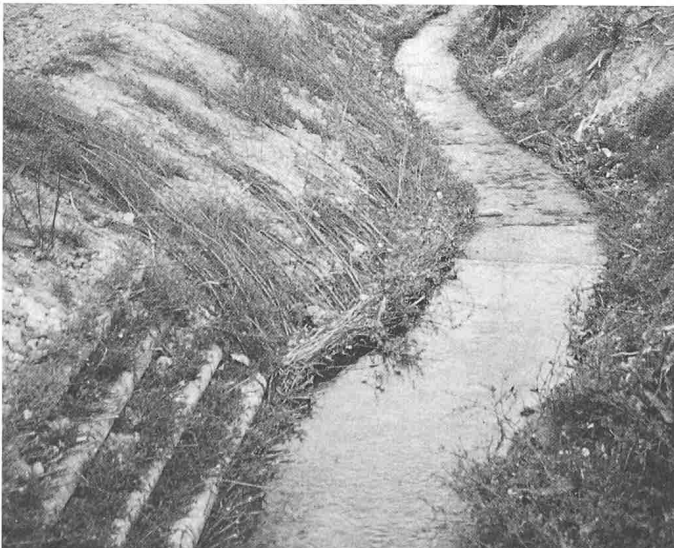
Bild 3. Schwarzbach: Spreitlage mit Uferfaschine und Holzgrünschwelle 1 Monat nach Einbau im Austrieb
