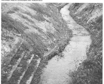
Bild 4. Schwarzbach: Ingenieurbiologische Uferstabilisierung mit Strukturmatte und Bepflanzung
