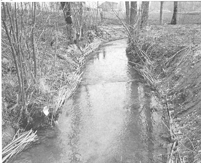
Bild 7. Rotbach: Unterspülte Gehölzufer werden mit Uferfaschinen unterfangen
