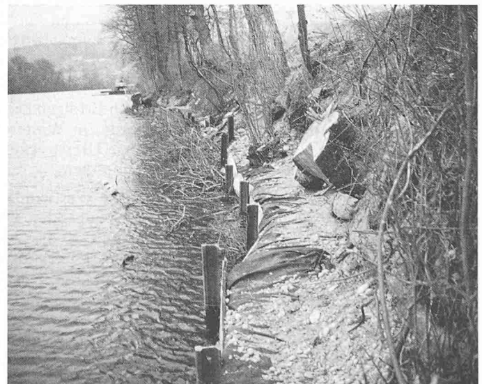
Bild 12. Häfli: Geotextilwalze hinter Eisenbahnschienen
