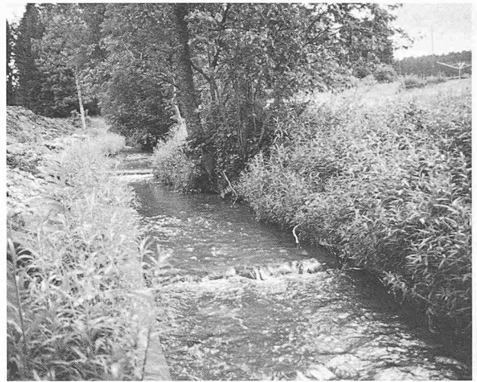
Bild 10. Rotbach: links Geotextilwalzen mit Buschlagen, rechts Spreitlage mit Uferfaschine, 2 Monate nach Einbau bereits völlig verwachsen
