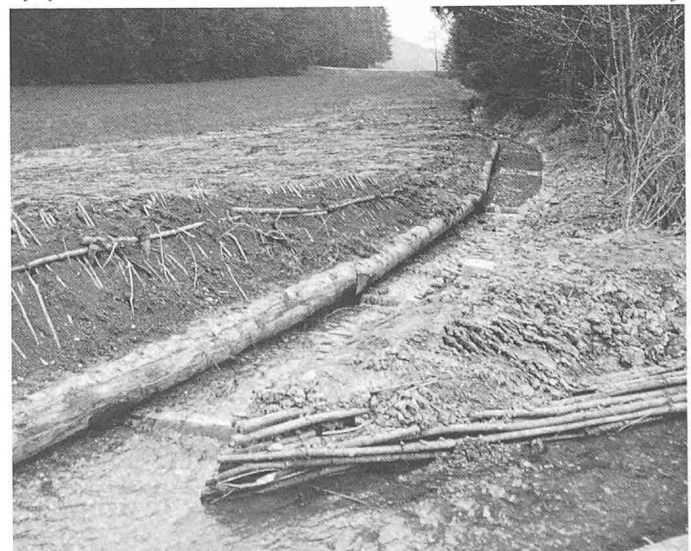
Bild 8. Rotbach: Spreitlage mit Längsholz als Fussicherung, im Vordergrund Uferfaschinen
