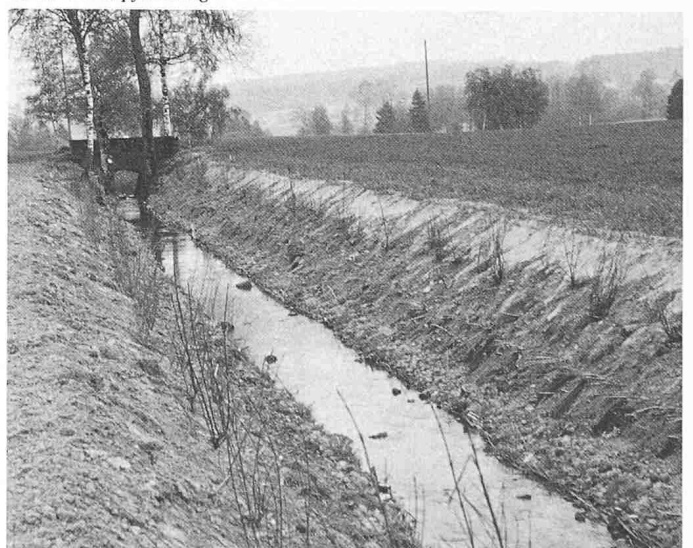
Bild 4. Schwarzbach: Ingenieurbioologische Uferstabilisierung mit Strukturmatte und Bepflanzung
