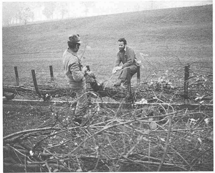
Bild 6. Rotbach: Bündeln von Weiden auf einer 4 m langen «Wedelmaschine»
