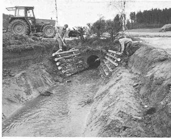
Bild 2. Schwarzbach: Holzgrünschwellen bei Ein- und Ausmündungen von Rohren werden vom Gemeindewerk erstellt
