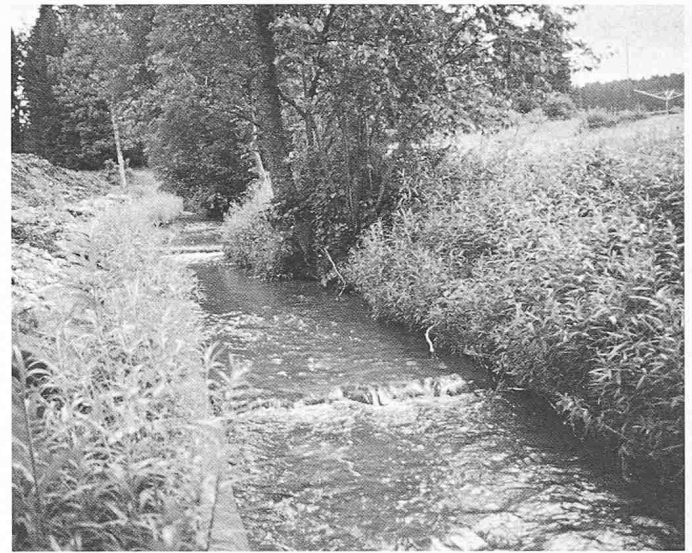
Bild 10. Rotbach: links Geotextilwalzen mit Buschlagen, rechts Spreitlage mit Uferfaschine, 2 Monate nach Einbau bereits völlig verwachsen
