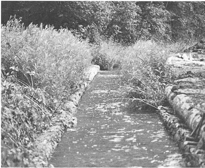
Bild 9. Rotbach: links Spreitlage mit Längsholz im Juli 1985, rechts Längsholz mit Buschlage neu und 2 Monate nach Einbau
