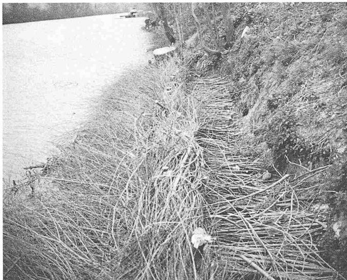
Bild 13. Häftli: Buschlage, mit Uferfaschine befestigt
