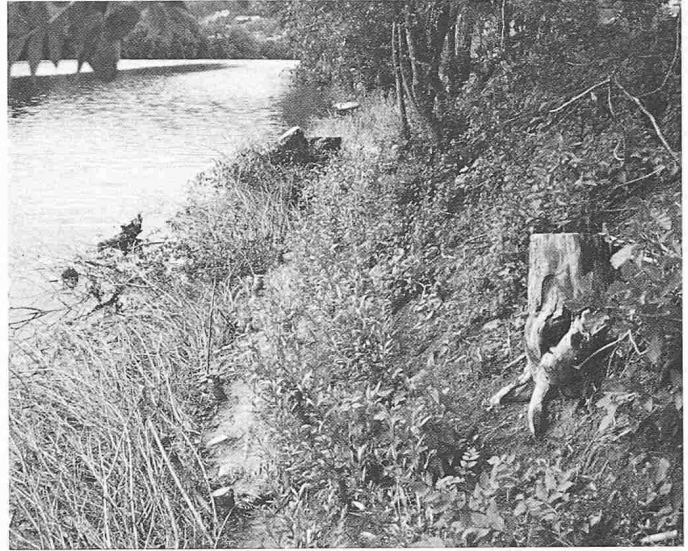
Bild 14. Häftli: Auffüllung, mit Steckhölzern besteckt, 2 Monate nach der Verbauung
