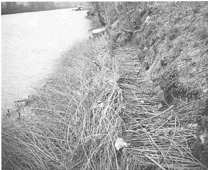
Bild 13. Häftli: Buschlage, mit Uferfaschine befestigt
