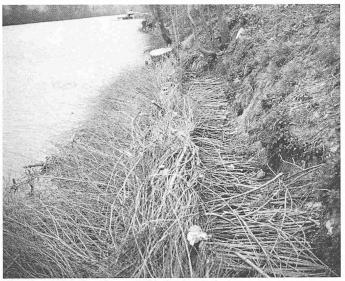
Bild 13. Häftli: Buschlage, mit Uferfaschine befestigt
