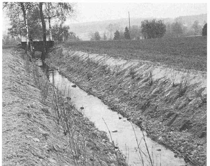
Bild 4. Schwarzbach: Ingenieurbioologische Uferstabilisierung mit Strukturmatte und Bepflanzung
