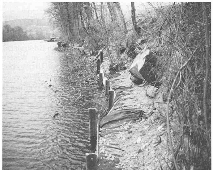
Bild 12. Häfili: Geotextilwalze hinter Eisenbahnschienen
