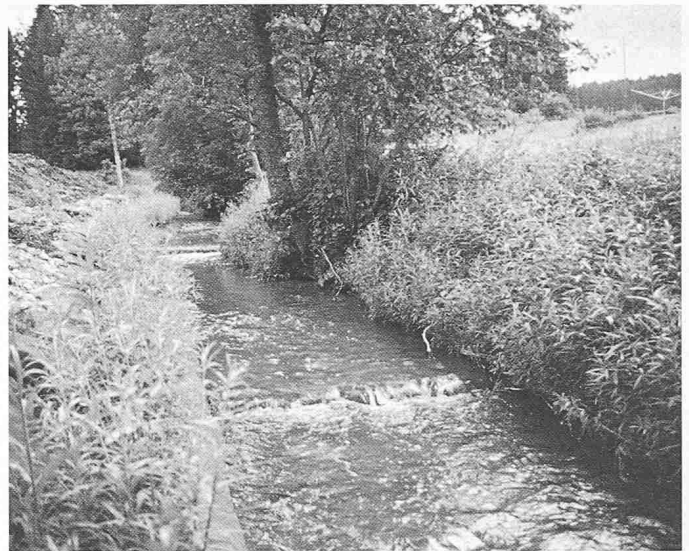
Bild 10. Rotbach: links Geotextilwalzen mit Buschlagen, rechts Spreitlage mit Uferfmaschine, 2 Monate nach Einbau bereits völlig verwachsen
