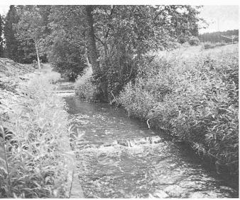
Rotbach: links Geotextilwalzen mit Buschlagen, rechts Spreitlage mit Uferfaschine, 2 Monate nach Einbau bereits völlig verwachsen
