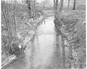
Bild 8. Rotbach: Spreitlage mit Längsholz als Fusssicherung, im Vordergrund Uferfaschinen
