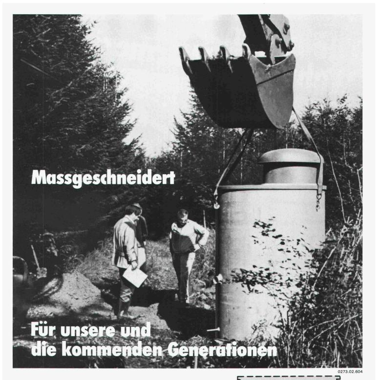
Zwei alte Brunnenstuben der Wasserversorgung Schenkon mussten ersetzt werden. Nach Angaben des projektierenden Ingenieurbüros werden die neuen Brunnenstuben in unserem Werk mit allen Einbauten und Anschlussstutzen hergestellt.
