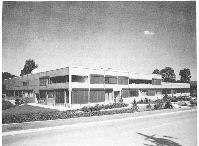
Bild 4. Grossflächige Alucobond-Fassadenplatten: Betriebsgebäude Gehring AG, Ballwil LU (3600×1250×4 mm)
