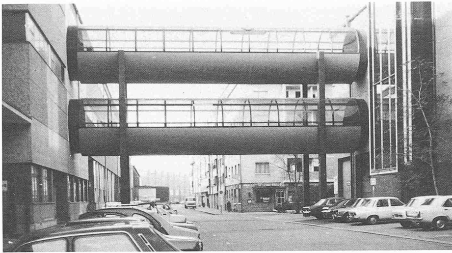
Bild 1. Die Passerelle für die Uhren- und Schmuckmesse an der Muba besteht aus zwei getrennten Röhren, die mit vier Kastenstützen rahmenartig verbunden sind
