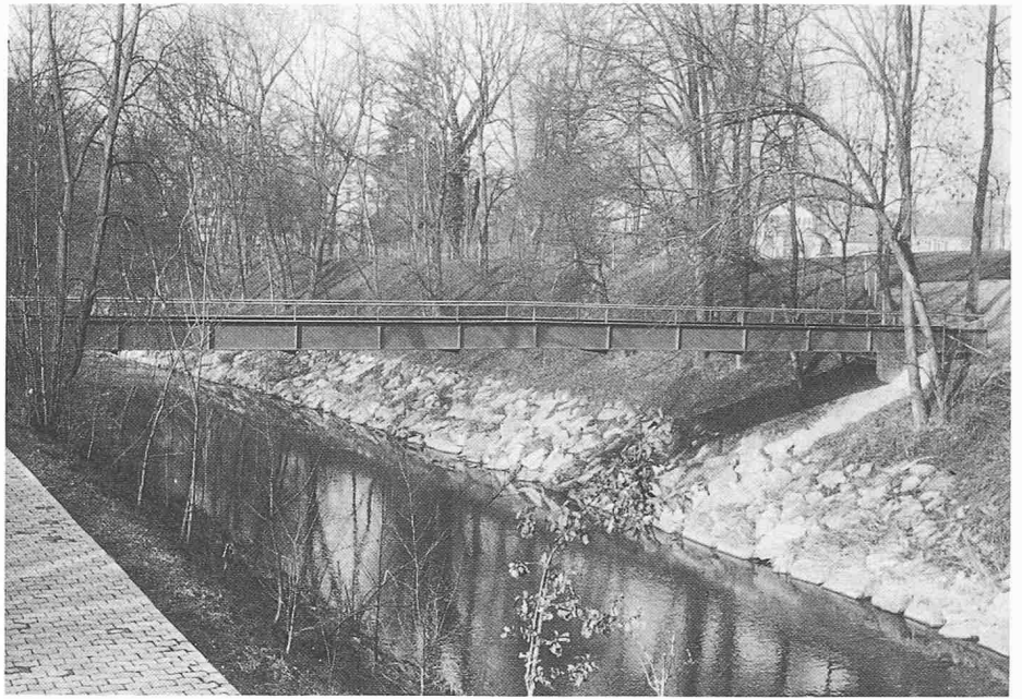
Bild 4. Fussgängerbrücke im Schwimmbad Frauenfeld, «Badisteg»
