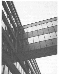
Die Stahlkonstruktion wurde nach der Strahlreinigung (Sa 21/2) mit einem Zinkstaubfarb-Grundanstrich versehen (2×40 μm). Die sichtbar bleibenden Teile erhielten zudem einen farbigen Deckanstrich.
