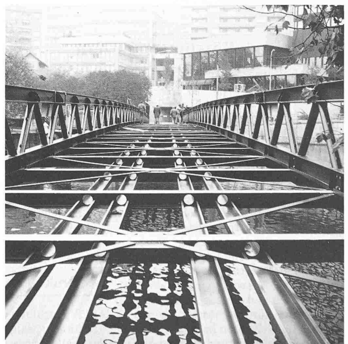
Bild 2 (rechts). Elegante Linienführung und sauber gestaltetes Tragwerk, noch ohne Fahrbahnplatte
