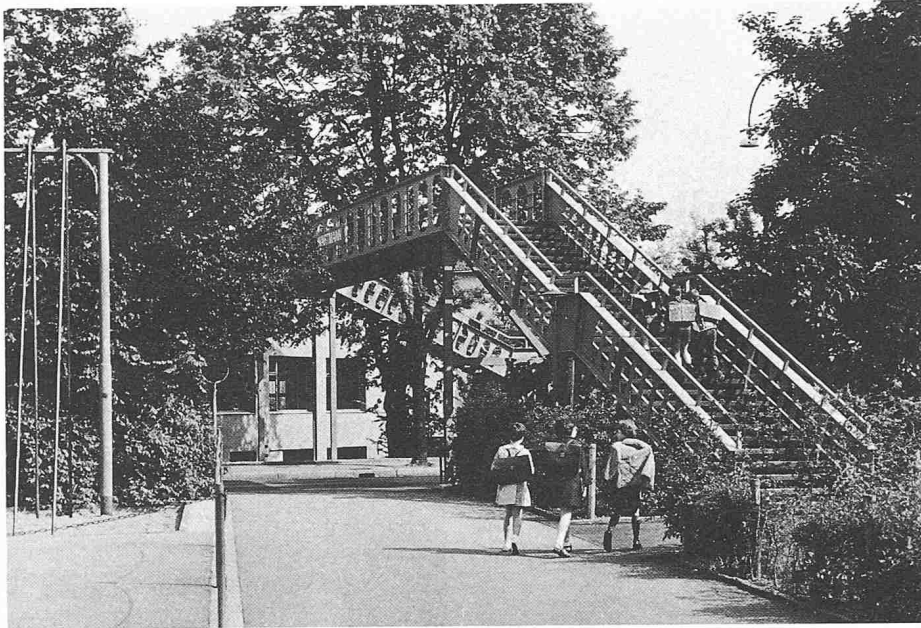
Bild 3. Zum Schutz der Schulkinder: Eine typische Überführung in Wabenträger-Konstruktion
