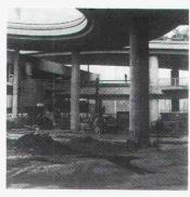
Die Pfahlfundation der Parkhauserweiterung des Einkaufszentrums «Glatt» in Wallisellen wurde wegen der gedrängten Platzverhältnisse und der Forderung nach einem erschütterungsfreien Einbauverfahren mit Ropress®-Pfählen im Hochdruck-Injektionsverfahren bewerkstelligt.
