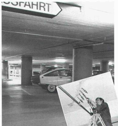
Bei undichten Stellen und Wassereinbrüchen in Tiefgaragen, U-Bahnen, Tunnels und anderen erdüberdeckten Bauwerken hat sich Renesco-Flexin als sicheres Abdichtungs-system bewährt. Flexin-Injektionen bewirken sofortige Abdichtung und dauerhafte Sanierung. Wir informieren Sie gerne ausführlich.
