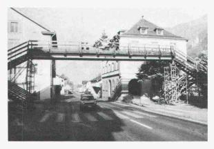
Wir projektieren und erstellen permanente oder provisorische Passerellen über Kantonsstrassen, Autobahnen, mehrspurige Eisenbahntrassees usw. Bei Provisorien kann das Material ohne Verlust für gleiche oder ähnliche Fälle wiederverwendet werden.
