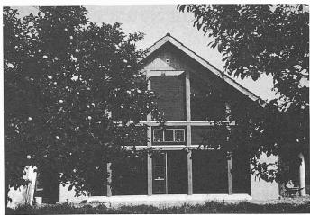
Haus M. Wieland, Oberglatt. Sonnenwärmesystem mit dunkler Lamellenstore im Luftraum von zwei Zweifachverglasungen bzw. Lamellen-Luftkollektor hinter Zweifachverglasung, sonnenzellengetriebenem Ventilator und Geröllwärmespeicher, Kachelofen, Warmwasserbereitung und Trocknung des Luftsystems mit Wärmepumpen-Boiler; Statik: Dr. W. Bosshard, Dübendorf
