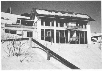
Haus Dr. H. Gmür, Gonten. Passives Sonnenwärmesystem mit Luftkollektoren und wärmespeichernder Betondecke im Schwerkraft-Kreislauf, Boiler-Vorwärmeregister, Zentralheizung vom Kachelofen im Wohnbereich; Statik: J. Hersche, Appenzell; lufttechnische Berechnungen: Dr. R. Kriesi, Benglen
