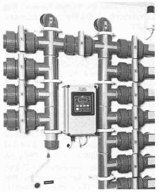
Bild 4. Wasseraufbereitungsanlage in einem Kantonspital. PVC-Rohrleitungssystem mit Fittings, Kugelbahnen und Durchflussmesser
