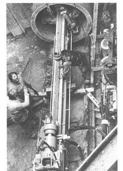
Bild 4. Bohrgerät auf Laffette im Schacht
