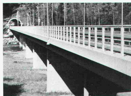
Autobahnbrücke Als frost- und tausalzbeständige Beschichtung
