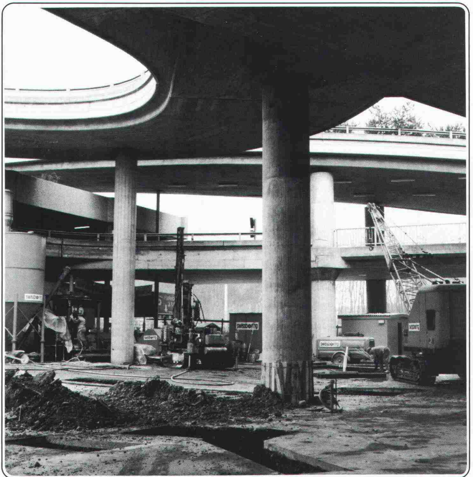
Wallisellen, <Glatt>-Zentrum Parkhauserweiterung. Pfähling nach dem System ROPRESS® mit Hochdruckinjektionen
