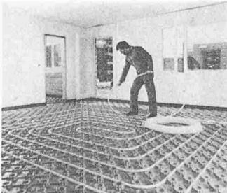
Distanzstege auf der Systemplatte welche das Rohr leicht vom Boden abheben und eine Umschliessung durch den Unterlagsboden sicherstellen; mehr Sicherheit in der Zeitspanne zwischen Verlegung und Ein-
