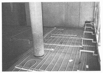
Nasszellen-Abdichtung Klosters: Nahtlose Abdichtung der Aufenthaltszonen mit Bodenheizung eines Hallenbades. Abdichtung auch von komplizierten Baukörpern mit Rohrdurchbrüchen, Säulen, Aufbordungen und Stufenkonstruktionen.
