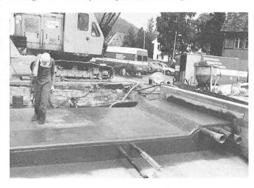
Bild 2. Tunnelabdichtung Walensee: Die nahtlos in einer Stärke von 2-3 mm aufgespritzte Vatec-Isolation ist dank der vollflächigen Haftung hinterwanderungsfrei und kann auf relativ «jungen» Beton mit einer Restfeuchtigkeit von bis zu 8 Gew.-% aufgebracht werden. Je nach Material und Schüttvorgang kann dank der mechanischen Widerstandsfähigkeit auf eine Schutzabdeckung ganz oder teilweise verzichtet werden.
