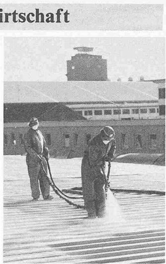
gen Bauformen und Untergründen an, ermöglicht eine fugenlose und somit Wärmebrückenfreie Dämmung und Abdichtung in einer Funktionsschicht.
