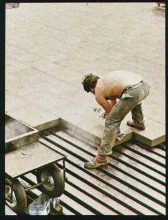
Flachdach auf Stahltrapezblech: FOAMGLAS T2 mit Heissbitumen im
