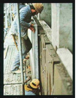
Hinterlüftete Fassaden mit offenfugigen, vorgehängten Elementen: FOAMGLAS T2 vollflächig und vollfugig mit Bitumenkaltkleber verlegt.
