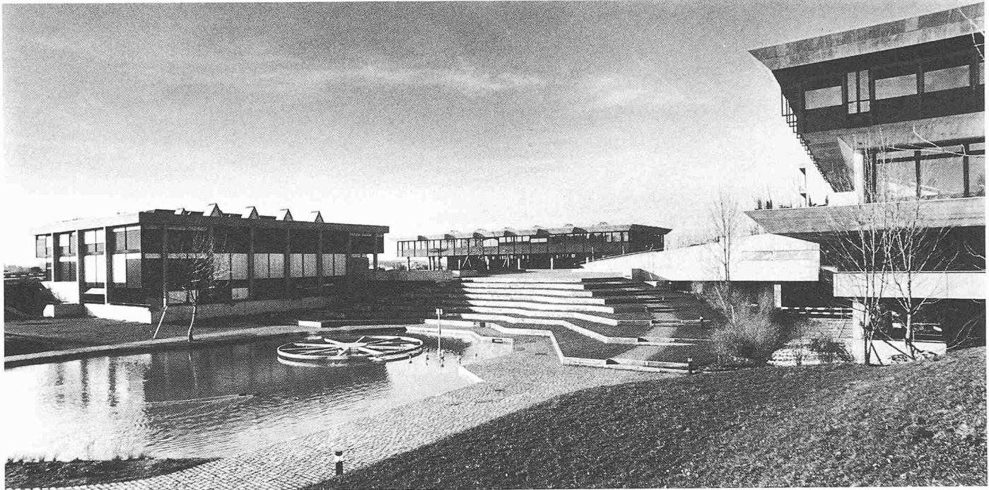
Theaterteich mit Sitzzone zwischen Mensa rechts und Staatsarchiv links. Im Hintergrund das Institut für Informatik
