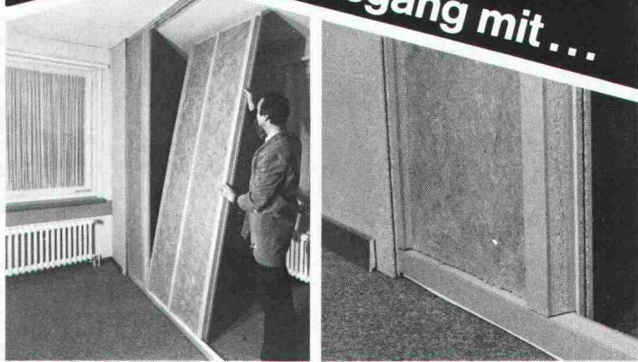
Trennwandelemente für Neubauten · Umbauten individuelle Raumgestaltung Die ideale Holztrennwand mit hoher Schall- und Wärmeisolierung. Schnelle, saubere und einfache Montage auch in bewohnten Räumen. Schalldämmwert lt. EMPA-Test 45 dB. Wandstärke 80 mm. Normgröße 260 x 93 cm.
