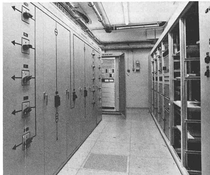
Bild 3. Niederspannungsverteilung mit Grobnetzverteiler, E-Technik-Schränken und Messtechnikschrank
