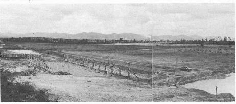
unregelmässige Topographie infolge natürlicher Entwässerungsrinnen auf; wegen der natürlichen Verwitterung nimmt die Schichtdichte gegen die Oberfläche hin ab. Die SPT-Tests ergaben Widerstände von etwa 20 bis 40 Schläge/Fuss an der Oberfläche, bei einer Tiefe von 4 bis 10 m nahm der Widerstand auf 100 Schläge/Fuss und mehr zu.
