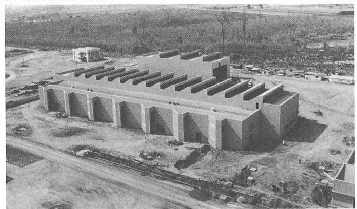
Bild 6. Werkstattgebäude. Sheddächer für minimale Sonneneinstrahlung. Hinten Braunkohlenmine
