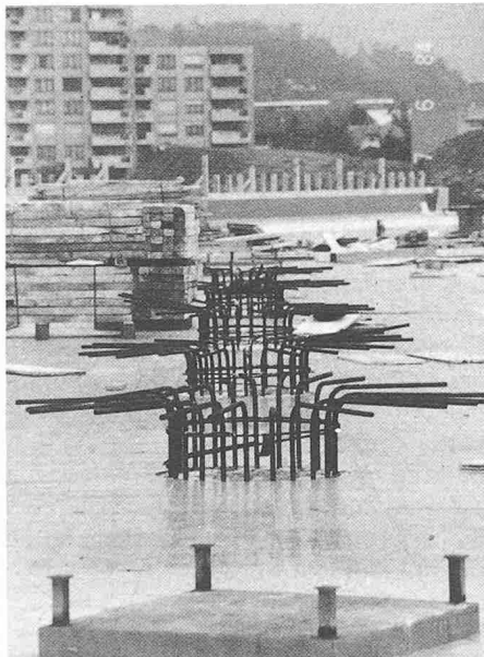
Bild 15. Kopfplatte zur Vergrösserung des Durchstanzkegels
