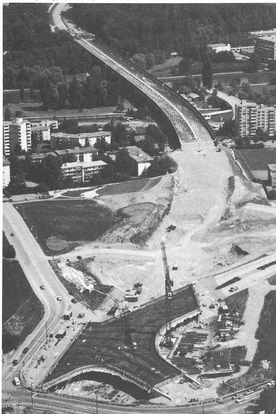
Bild 1. Übersicht. Unten das Bauwerk Überführung Bernstrasse, im oberen Bildteil das Anschlussbauwerk Limmatüberquerung (SIA 1981, Heft 8, Seite 166). Foto Swissair
