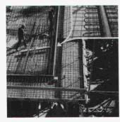
EGCO - wärmedämmender Kragplattenanschluss, stützenfrei
