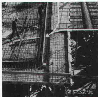
EGCO - wärmedämmender Krag- plattenanschluss, stützenfrei
