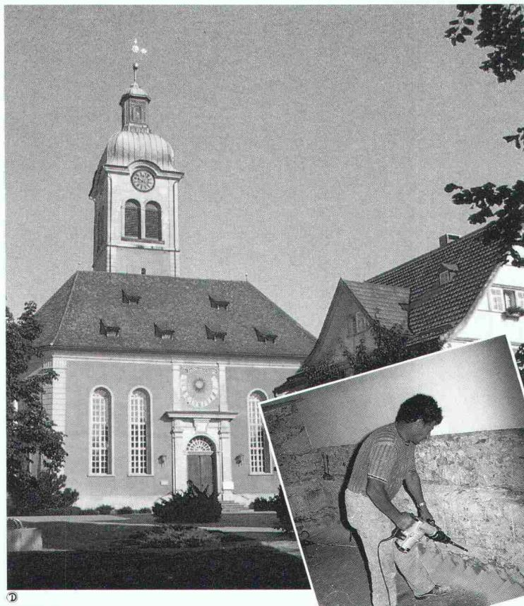
Feuchtes Mauerwerk an historischen und neueren Bauten lässt sich mit modernen Renesco-Methoden wirkungsvoll sanieren. Eine Horizontalsperre mit Renescon-Injektionen verhindert das Aufsteigen von Feuchtigkeit und legt die Mauer trocken. Ein für allemal. Wir informieren Sie gerne ausführlich.
