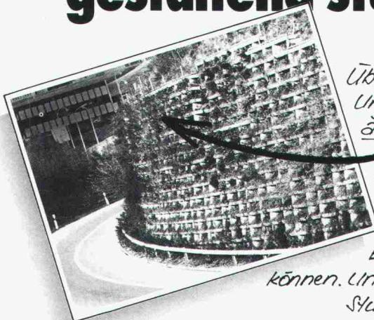
Überall, wo ein steiler Abhang Unterstützung braucht und erst noch ästhetisch aussehen soll, ist Murflex® mehr als am Platz. Die optimal begrünbare Raumgitter-Konstruktion, mit welcher – flexibel – entsprechend den örtlichen Gegebenheiten auch Nischen, Abstiege und Ecken ausgebildet werden können. Und – die in Notfällen innerst Stunden ab Lager lieferbar ist.
