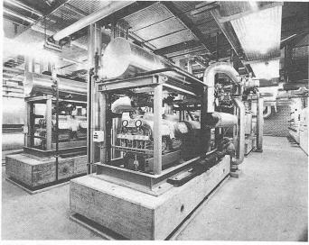
Bild 3. Wärmepumpen
