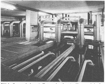
Bild. 4. Seewasserbecken mit Plattenverdampfern, im Hintergrund der Seewassereinlauf
