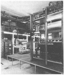
Blockheizkraftwerk (Totalenergieanlage); rechts im Vordergrund Gasmotor, im Hintergrund links Wärmerückgewinnung von Motor- und Abgas-
