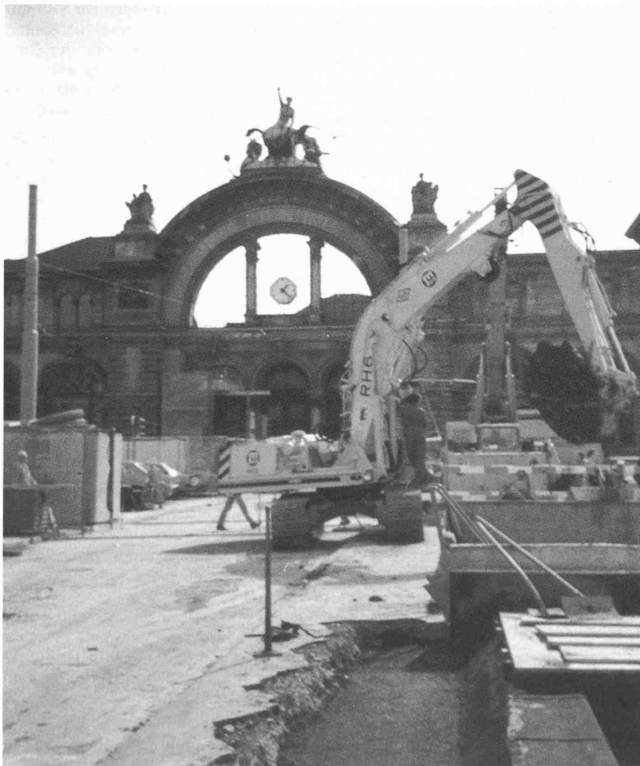
Bild 1. Aushubarbeiten für Untergeschoss bei Deckelbauweise
