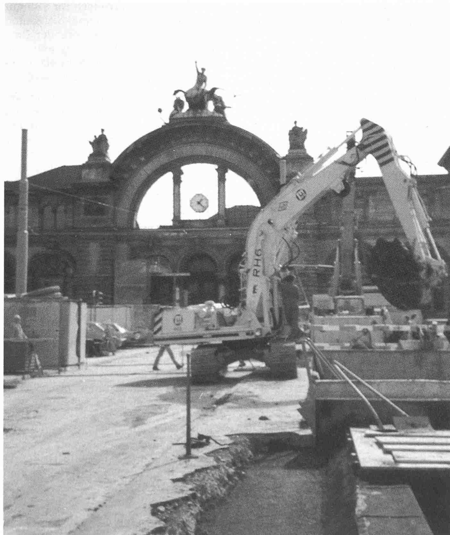
Bild 1. Aushubarbeiten für Untergeschoss bei Deckelbauweise
