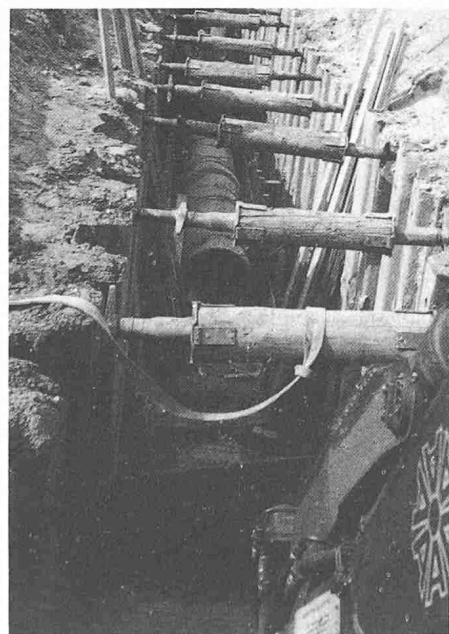
Rohrverlegung auf vorbereiteter Betonsohle im gespundeten Graben auf der Höhe des Grundwasserspiegels
