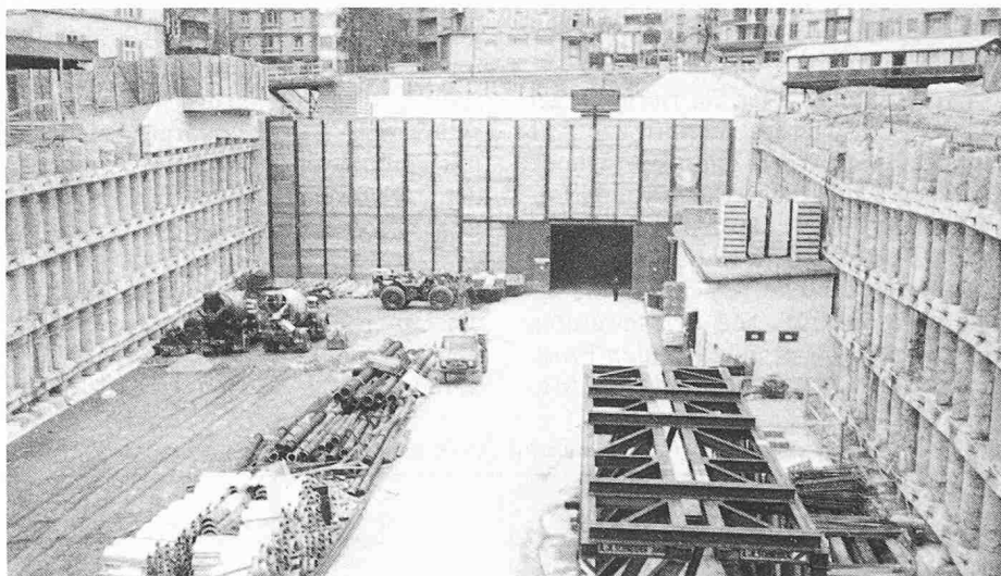
Bild 1. Lärmschutzhülle im Voreinschnitt Süd mit schalldichtem Tor, das nachts geschlossen blieb
