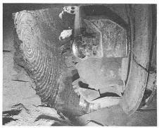
Bohrkopf der Robbings-Tunnelbohrmaschine mit 3,20 m Durchmesser
