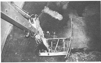
Befestigung der Bewehrungsmatten. Die weisse Zone oberhalb des Arbeitskorbes entstand wegen eines naheliegenden Gefrierrohrs
