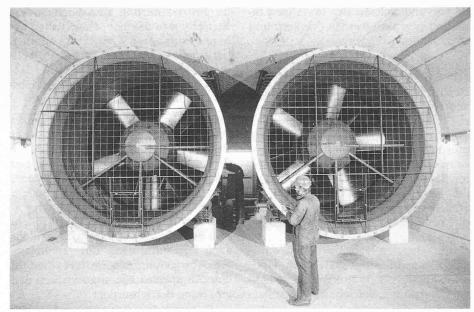
Bild 2. Ventilatoren in der unterirdischen Lüftungszentrale
