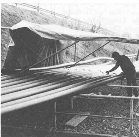
Bild 3. Verschweissen der Rohrstücke mittels Elektroschweissmuffen in Melide
