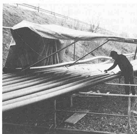
Bild 3. Verschweissen der Rohrstücke mittels Elektroschweissmuffen in Melide
