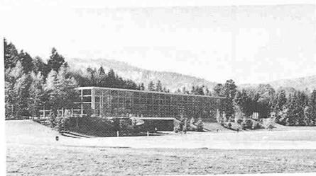
Polyvalente Grosssporthalle 44×84 m, Höhe 11 m, mobil einbaubare Rundbahn, mit 50 m freier Spannweite, vormals grösste Halle dieser Art
