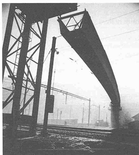
Pont mixte d'une longueur de 530 m avec des portées jusqu'à 81 m, fondé sur des pieux flottants de 30 m, lancement du caisson métallique et bétonnage de la dalle avec un chariot de coffrage
