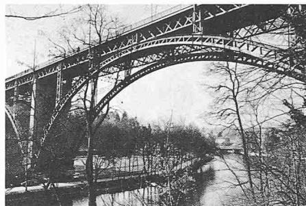
Une des œuvres maîtresses de la construction en fer en Suisse; 2 travées d'une portée de 81 m, supportant des arcs en treillis sur lesquels s'appuient le tablier par l'intermédiaire de piliers en treillis
