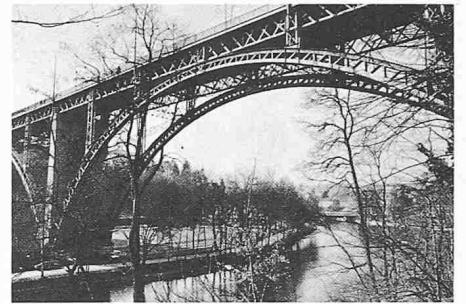
Une des œuvres maîtresses de la construction en fer en Suisse; 2 travées d'une portée de 81 m, supportant des arcs en treillis sur lesquels s'appuient le tablier par l'intermédiaire de piliers en treillis
