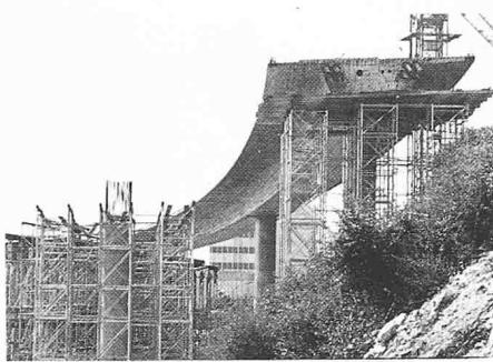
kasten in teilweise vorgespanntem Stahlbeton, vorfabizierte Betonbretter für Schalung der Fahrbahnplatte
