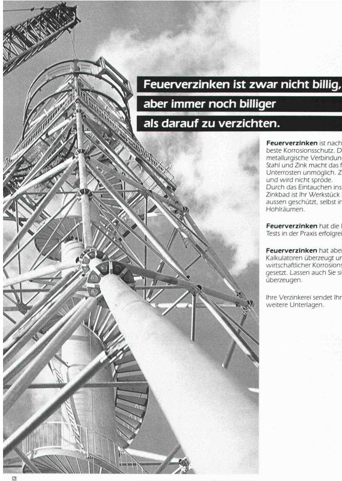
Feuerverzinken ist nach wie vor der beste Korrosionsschutz. Die einzigartige metallurgische Verbindung zwischen Stahl und Zink macht das folgenschwere Unterrosten unmöglich. Zink bleibt zäh und wird nicht spröde. Durch das Eintauchen ins 450° heisse
