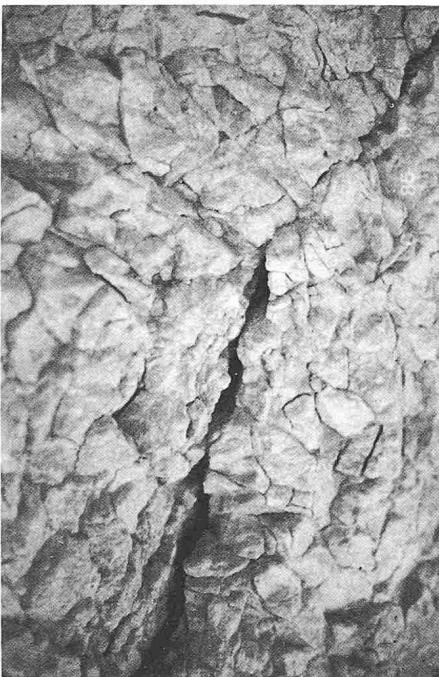
Bild 7. Kluft im Malmkalk des grossen Felsens nach der Reinigung, vor dem Ausfüllen (Foto Gubler, Laich SA)
