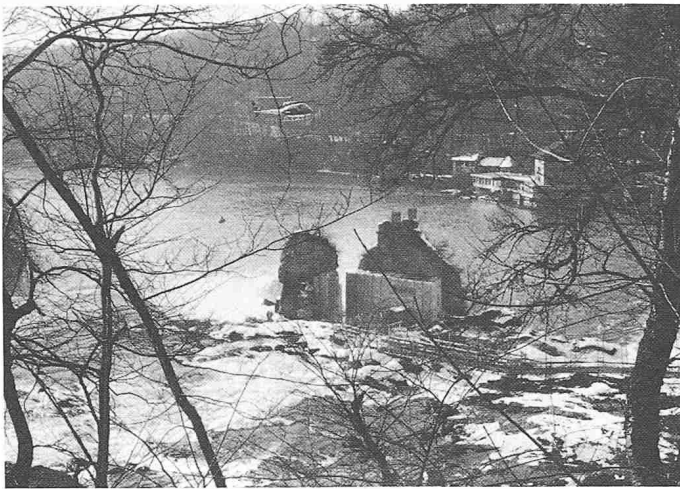
Bild 4. Gesamtübersicht der Baustelle (Foto Gsell)
