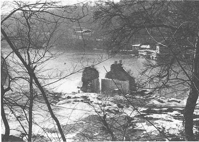
Bild 4. Gesamtübersicht der Baustelle (Foto Gsell)
