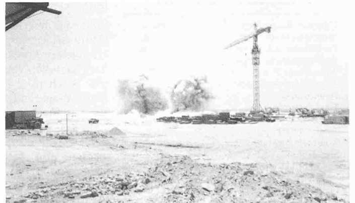
Bild 13. Sprengarbeiten. Pre-splitting
