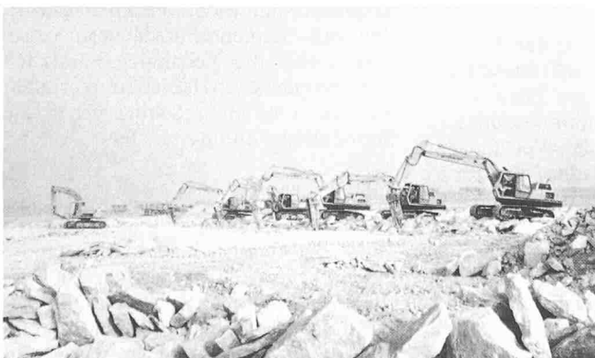
Bild 12. Grossflächen-Felsaushub mittels Hydraulikhämmern
