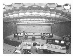
Bild 10. Kontrollraum mit SCADA-8-Steuerungsanlage
