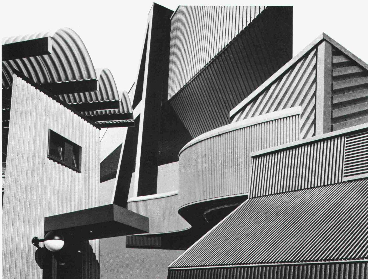
Aluminium-Wellbänder sind leicht und bieten deshalb Vorteile bei Konstruktion und Montage. 4 Typen sind ab Lager ALLEGA erhältlich. Andere Wellungen, Dicken und Oberflächen, wie stucco geprägt und einbrennlackiert, sind ab Werk lieferbar. Zahlreiche Befestigungszutaten erlauben eine rationelle Montage. Aluminium-Wellbänder sind korrosionsbeständig und garantieren jahrzehntelange Lebensdauer.
