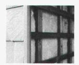
Stero-Crete-Platten werden nach neuesten Produktionstechniken aus Zementmörtel hergestellt.
