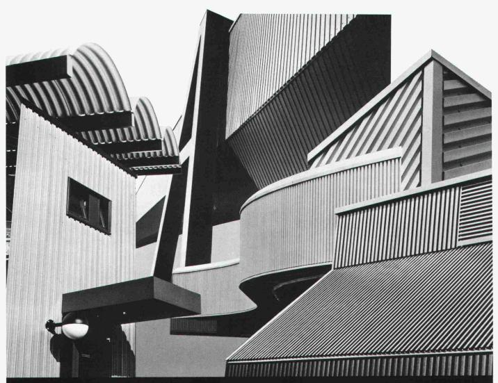
Aluminium-Wellbänder sind leicht und bieten deshalb Vorteile bei Konstruktion und Montage. 4 Typen sind ab Lager ALLEGA erhältlich. Andere Wellungen, Dicken und Oberflächen, wie stuccogeprägt und einbrennlackiert, sind ab Werk lieferbar. Zahlreiche Befestigungszutaten erlauben eine rationelle Montage. Aluminium-Wellbänder sind korrosionsbeständig und garantieren jahrzehntelange Lebensdauer.
