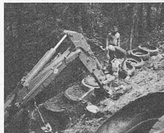
Bild 1. Begrünbare Böschungsbe- wehrung aus Altreifen Bild 2. Sanieren einer Hang- rutschung
