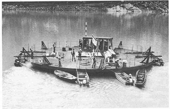
Bild 7. Das untere Einlaufbauwerk des Pumpspeicherwerkes Grimsel-Oberaar während des Einschwimmens (1976). Das Betonbauwerk gleicht einem Hohlzylinder mit 21,70 m Durchmesser und 7,25 m Höhe. Sein Gewicht beträgt 1200 t, sein Auftrieb wird durch rund 1000 m 3 Polystyrol-Hartschaumstoff gewährleistet (Foto IUB).
