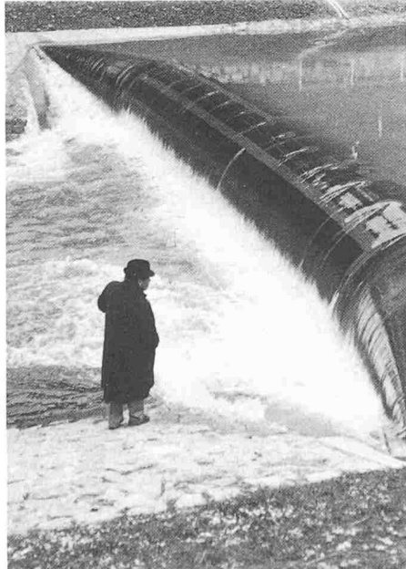
Bild 2. Das Schlauchwehr Hochfelden in der Glatt als Notverschluss für ein Ölwehr-Dispositiv. Stauhöhe 1,6 m, Schlauchlänge 22 m, Material 5 mm starker Neopren Gummi mit Nylongewebe (Foto VAW).
