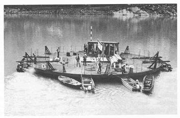
Bild 7. Das untere Einlaufbauwerk des Pumpspeicherwerkes Grimsel-Oberaar während des Einschwimmens (1976). Das Betonbauwerk gleicht einem Hohlzylinder mit 21,70 m Durchmesser und 7,25 m Höhe. Sein Gewicht beträgt 1200 t, sein Auftrieb wird durch rund 1000 m3 Polystirol-Hartschaumstoff gewährleistet (Foto IUB).
