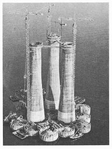
Bild 9. Die «Condeep»-Bohrplattform in Nordsee. Auf der schwimmenden Bodengruppe werden die drei Pfeiler der Plattform und dann die Plattform selbst aufgebaut, Anschliessend wird das Ganze vor Ort geschleppt und abgesenkt. Gesamthöhe fast 160 m, Gesamtgewicht rund 160 000 t
