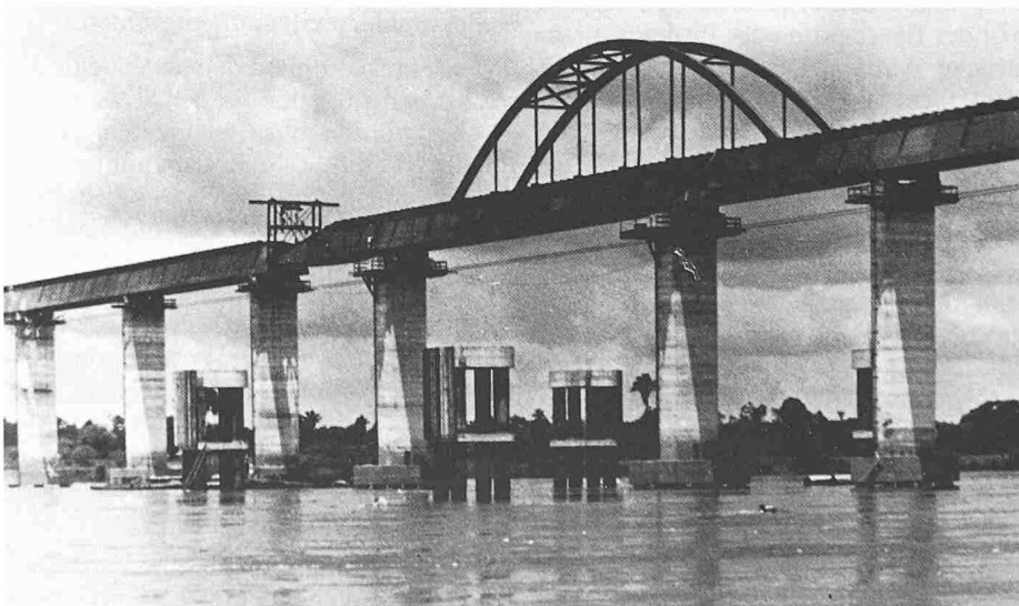
Bild 5. Bogenversteifter Hauptträger für die Schiffsöffnungsöffnung der Tocantins-Verbundbrücke während des Längsvorschubes
