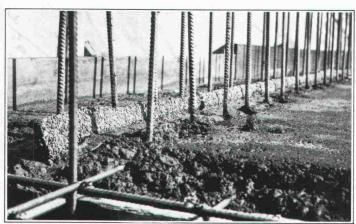
Erstellen einer Anschluss-Dichtung "BFL-MASTIX" Typ 20/70 R4.
