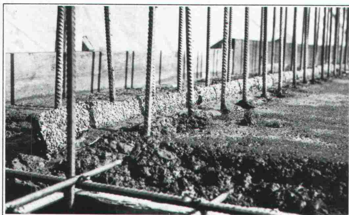
Erstellen einer Anschluss-Dichtung "BFL-MASTIX" Typ 20/70 R4.
