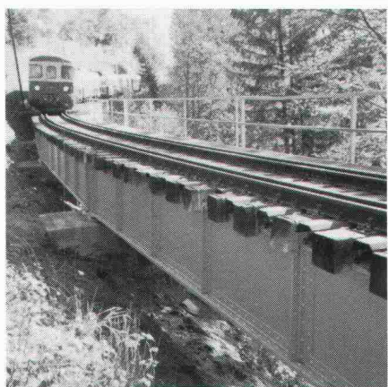
Rufenenbrücke auf der Strecke Spiez-Zweisimmen. Ausgeführt mit METALLOGAL®
