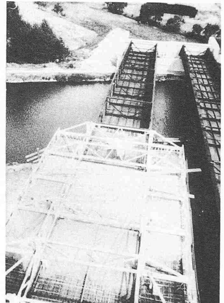
Bild 5. Schalgerüste im Einsatz
