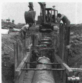
Hobas-Rohre (GUP) in Anwendung in den schwierigsten Situationen, wo die Verwendung anderer Rohre undenkbar ist. Verwendung im schwierigen Gelände: Hangleitungen, Düker, Seeleitungen, Brückenleitungen und in schlechtem Baugrund mit gespriessten Gräben.
