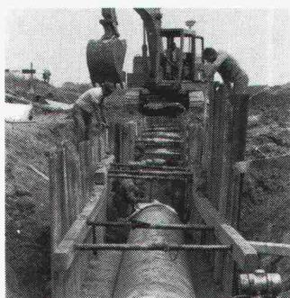
Hobas-Rohre (GUP) in Anwendung in den schwierigsten Situationen, wo die Verwendung anderer Rohre undenkbar ist. Verwendung im schwierigen Gelände: Hangleitungen, Düker, Seeleitungen, Brückenleitungen und in schlechtem Baugrund mit gespriessten Gräben.
