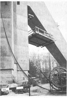
Bild 2. Einziehen von Drahtbündeln in vorverlegte Hüllrohre
