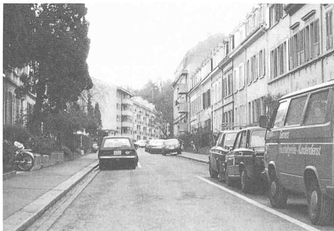
Bild 1. Wechselseitiges Längsparkieren, Typ A
