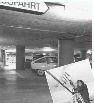
Bei undichten Stellen und Wassereinbrüchen in Tiefgaragen, U-Bahnen, Tunnels und anderen erdüberdeckten Bauwerken hat sich Renesco-Flexin als sicheres Abdichtungs-system bewährt. Flexin-Injektionen bewirken sofortige Abdichtung und dauerhafte Sanierung. Wir informieren Sie gerne ausführlich.
