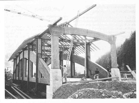
struktion weist beachtenswerte Neuerungen auf: druckimprägnierte, verleimte Buche für die Hängepfosten und Querträger; Fahrbahnplatte aus 20 cm breiten, hochkantgestellten und druckimprägnierten Tannenholzlamellen verleimt. Die Fahrbahnplatte wurde in drei Teilen angeliefert, an Ort zu einem Stück verleimt und anschliessend mit Spannstählen quervorgespannt.
